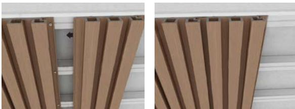
**C.** Es importante dejar una dilatación de 5 mm en la unión de dos Wallpanel® y en los encuentros o remates perimetrales, para permitir que se expanda y se contraiga libremente.
